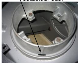
So sieht der fertige Kondensatablauf aus.
